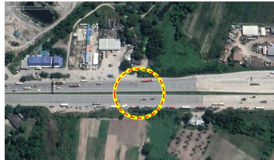
สภาพปัจจุบัน (หลังเปิดให้บริการระบบปิด
